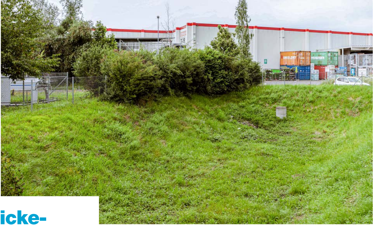
Diese Versickerungsmulde in Schlieren zeigt den grossen Platzbedarf bei herkömmlicher Dimensionierung. «Mutiger» und heute zulässig würde etwa ein Viertel der Grösse genügen. Wichtig bleibt ein kontrollierter Überlauf in die Kanalisation (Schacht hinten). Quelle: Jäckli Geologie AG
